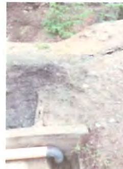
CANAL, REPARACION CANAL POR ASOLVAMIENTO POR SUELO ARRASTRADO POR LLUVIA
