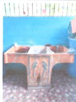
Mantenimiento estufa rural, cambio de plancha, instalacion chimenea, reparacion de recubrimiento en mal estado, sustitucion de pila interna de cocina con fuga
